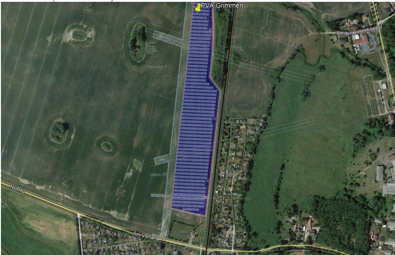
Bild 2.1.3: Detailansicht der PV Fläche (Quelle: Google Earth/SolPEG)
